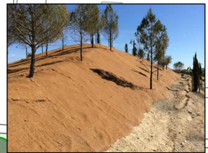
PROTECCIÓN DE TALUDES CON MANTA DE COCO BIODEGRADABLE
