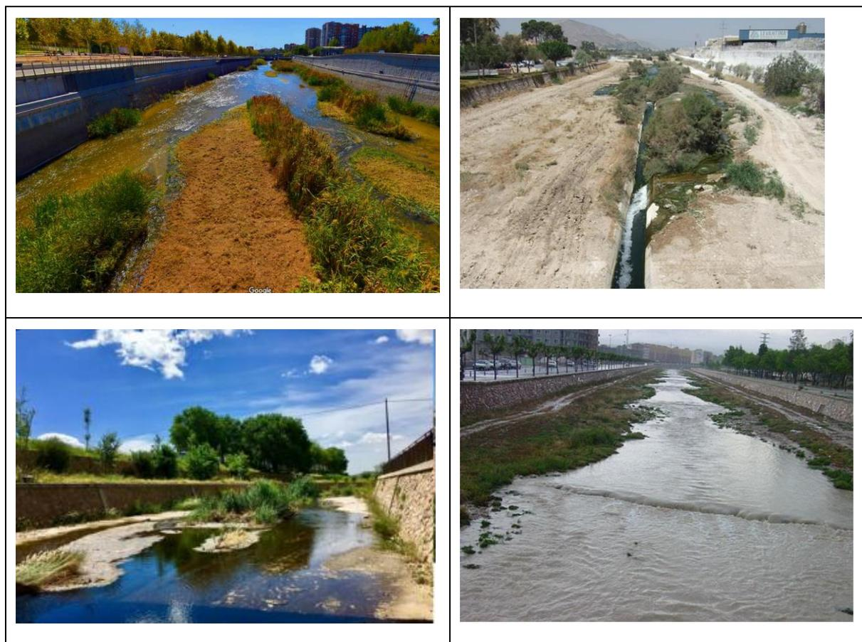
Imagen 12:: Cauces naturalizados (eliminación solera hormigón en cauce)
